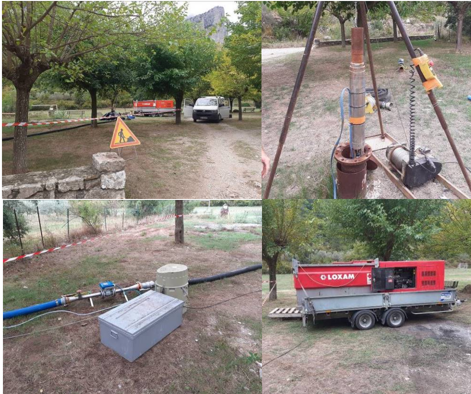
Figure 5 : Mise en place de la pompe immergée / Colonne d'exhaure
