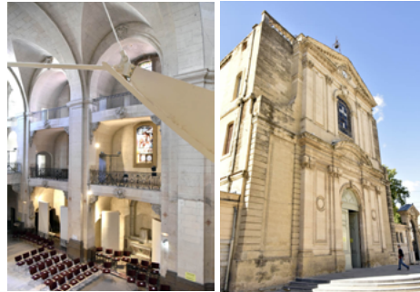
Maison des chœurs
